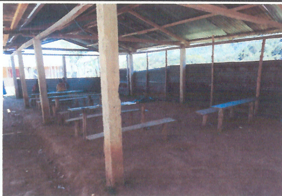
Foto 1: Mejoramiento de modulo 1
